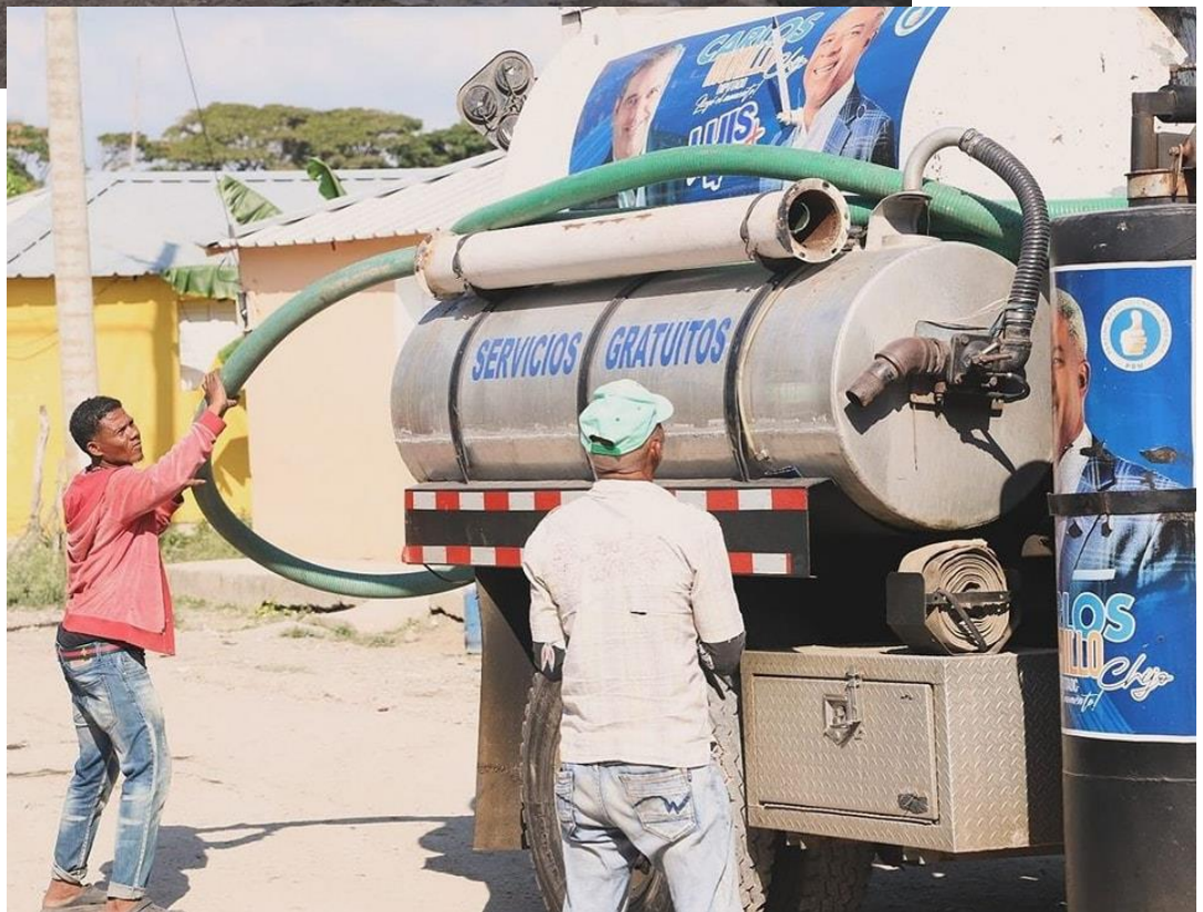
Limpieza de pozo séptico.
