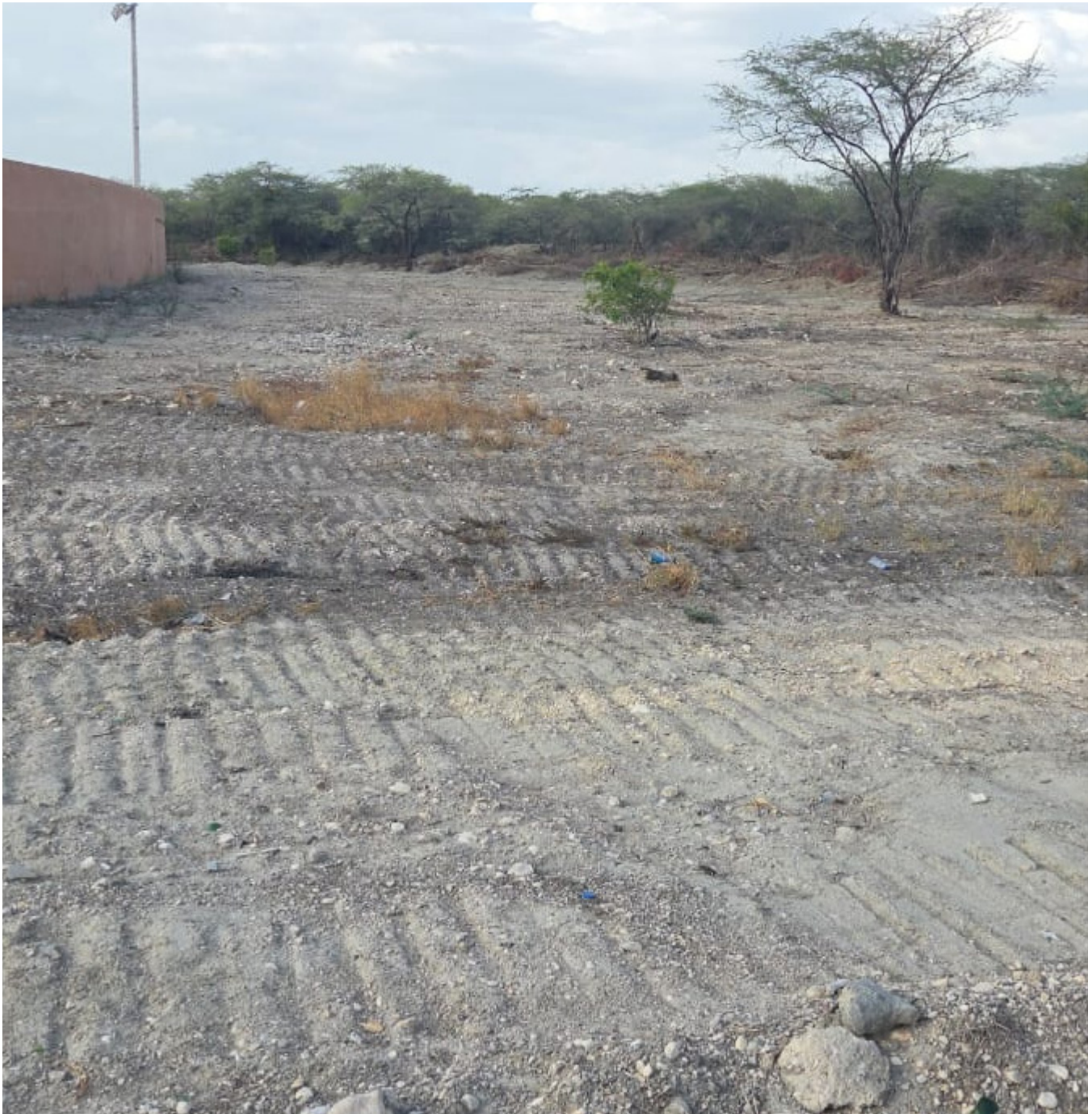
Desmonte para la construcción de un arboleto en el pueblo de La Colonia con la cooperación del Distrito Municipal, Fundación Sur Futuro y la Dirección General de Embellecimiento de carreteras
