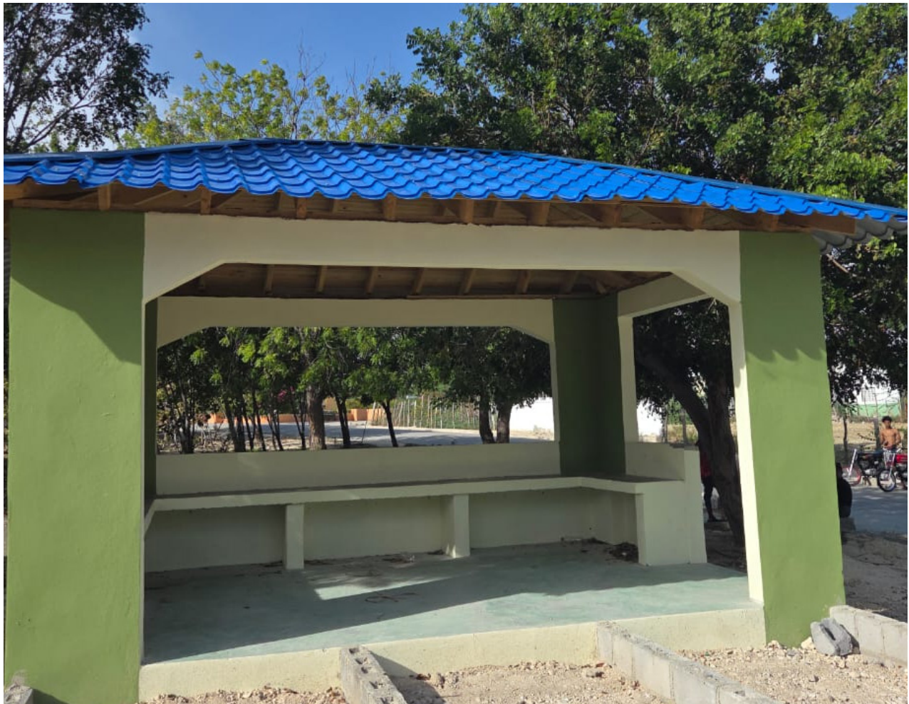
Caseta en construcción como parada publica de vehículos Distrito La Colonia de Mella
