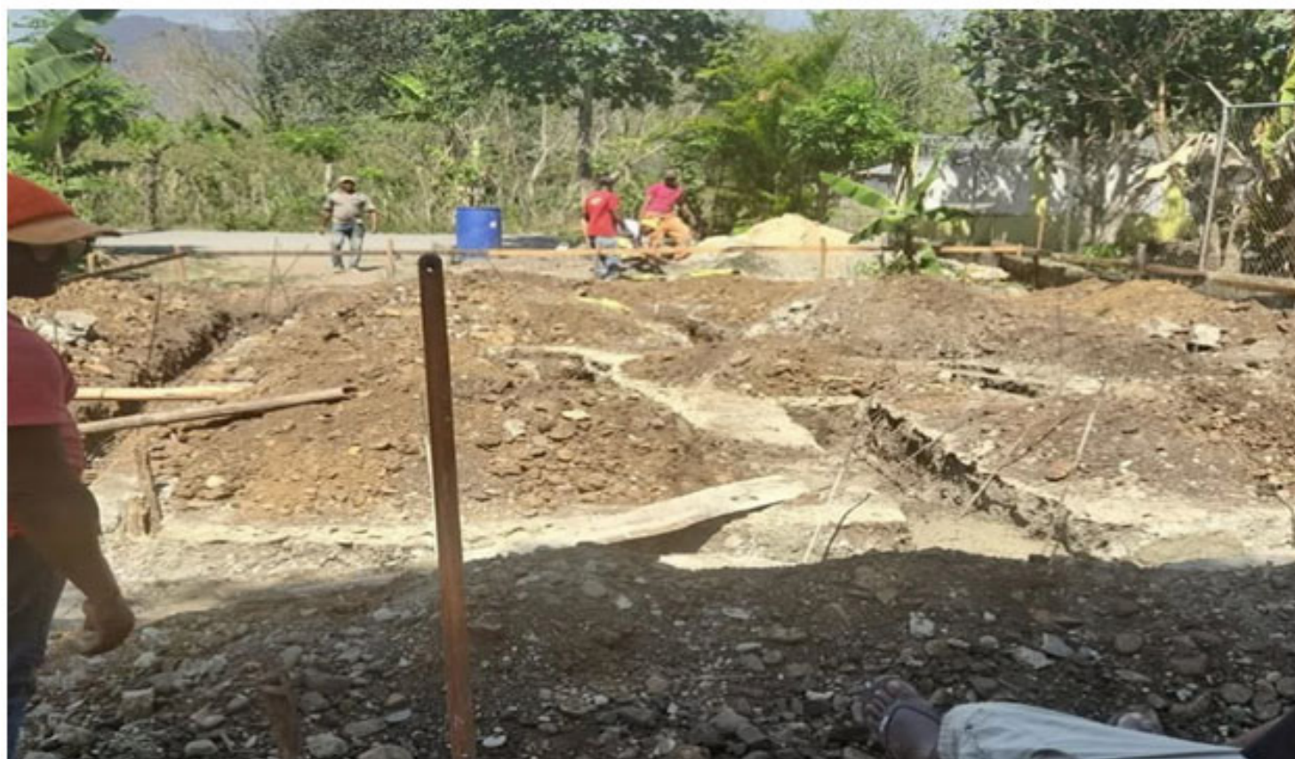
Frank Paulino: Esta imagen significa mucho para mí, por que es el inicio de la casa de "Doña Fina" en Villa Altagracia, una de 10 casas que gestionamos a través del Ministerio de Obras Públicas.
